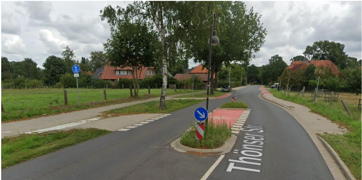
Abbildung 50 Querungshilfe an der Ortsgrenze. Der Fahrbahnteiler erlaubt den sicheren Wechsel zwischen dem einseitigen Geh- und Radweg (außerorts) und der richtigen Fahrbahnseite (innerorts). Die Mittelinsel dämpft die Geschwindigkeit des einfahrenden Verkehrs.
