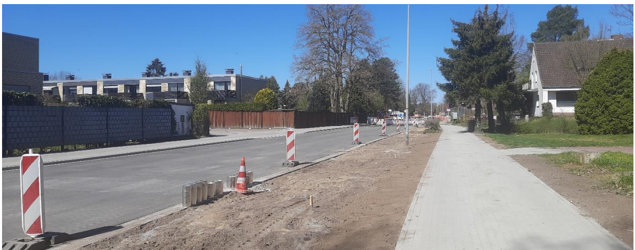
Abbildung 28 Baustelle Fuhrberger Straße
