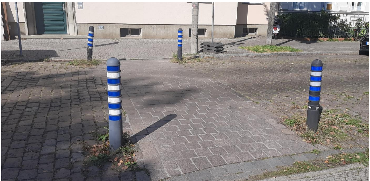
Abbildung 66 Diese Fußgängerfurt wurde im unter Berücksichtigung des Denkmalschutzes mit geschliffenem Pflaster ausgelegt. Es fehlen taktile Leitelemente, so dass nur eine bedingte Barrierefreiheit erreicht wird.
