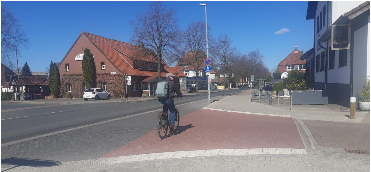
Abbildung 21 Einmündung Hannoversche Straße / Pestalozzistraße mit neuer Furt
