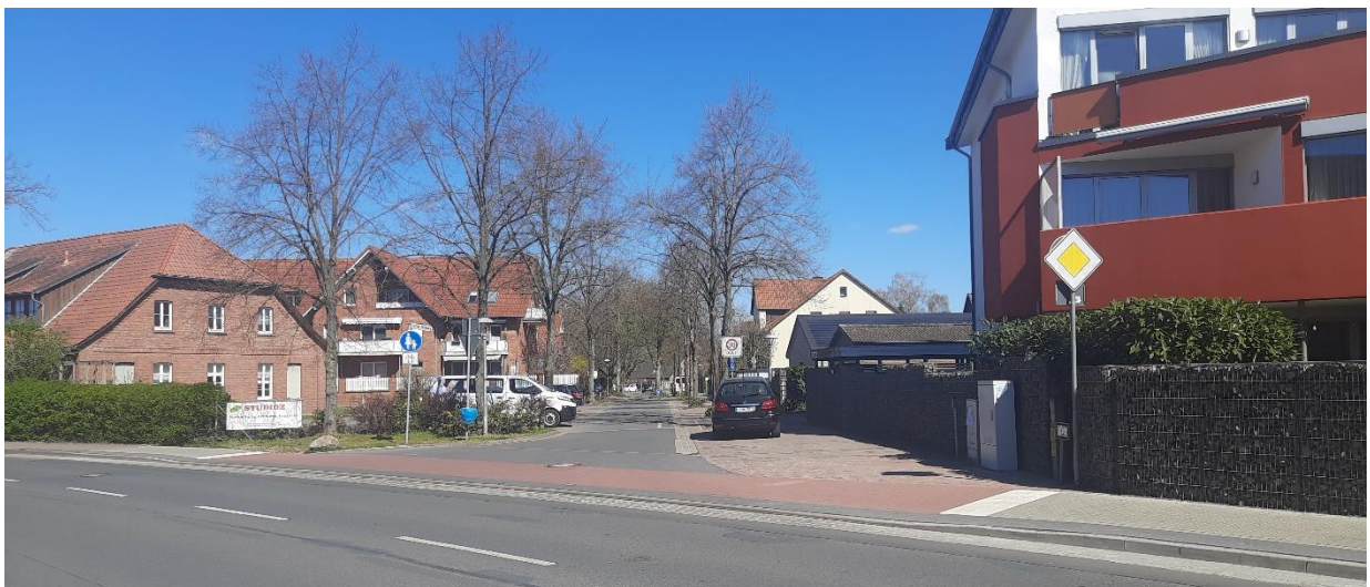
Abbildung 20 Einmündung Hannoversche Straße / Alter Postweg mit neuer Furt
