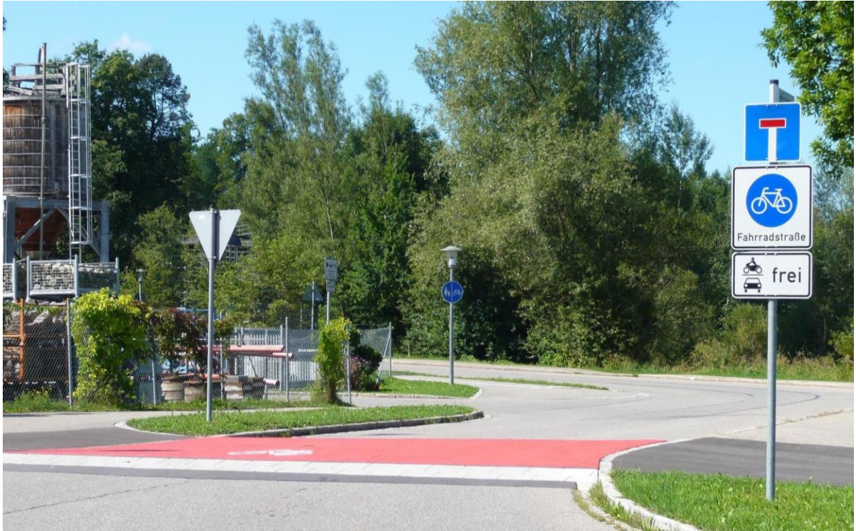
Abbildung 48 Aufgepflasterte Furt an einer einmündende Straße
