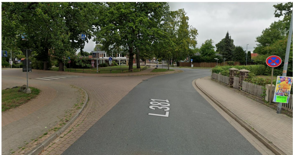
Abbildung 79 Die schlecht einsehbare „Feuerwehkreuzung“.
