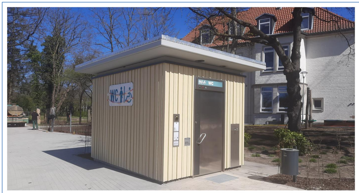
Abbildung 70 Öffentliches WC am Rathaus kurz vor der Inbetriebnahme
