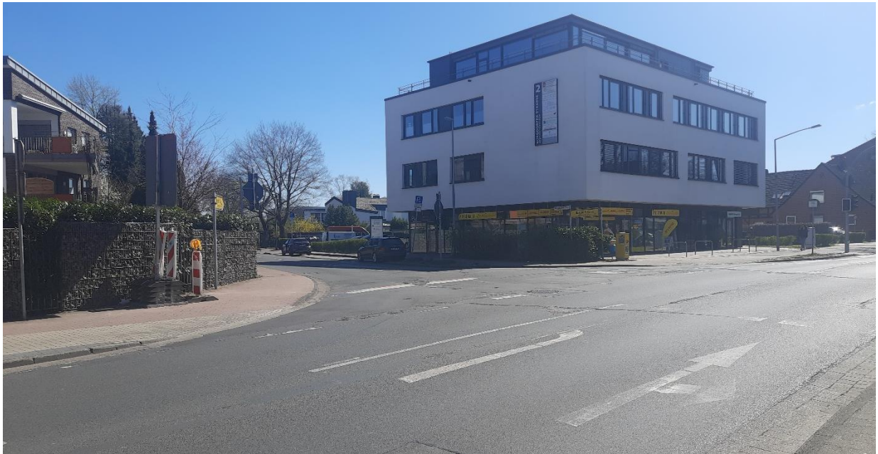
Abbildung 19 Einmündung Hannoversche Straße / Burgdorfer Straße
